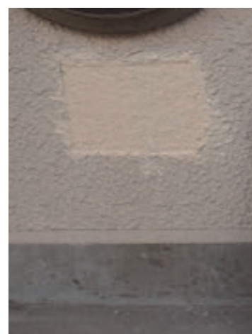
採取痕の簡易塗装補修例
