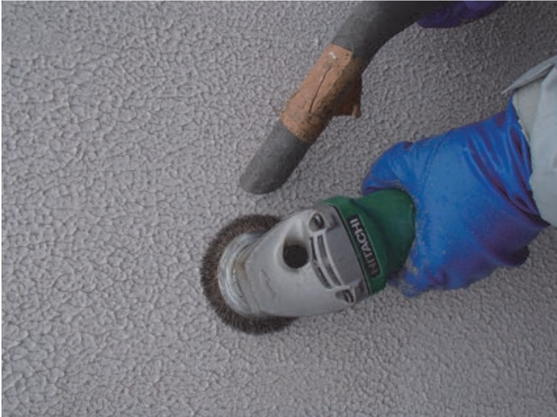
③HEPA フィルター付掃除機による集じんの事例写真
