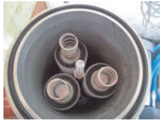
写真8 膜ろ過フィルターの支持部
