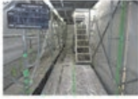
足場内部の養生(例)
