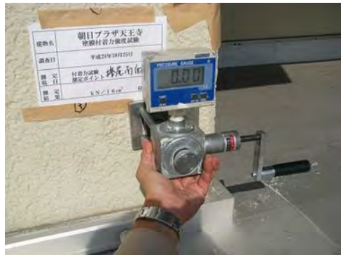
試験器設置、測定
