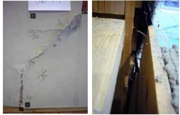
開口左下隅部の亀裂 / 窓台左端部腰壁浮き
