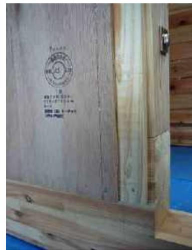
写真 3.3.4 ホールダウン金物 写真 3.3.5 構造用合板下地 写真 3.3.6 構造用合板縦張り
