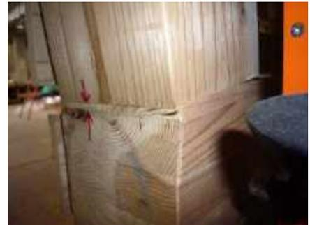
写真 3.3.30 柱脚のめり込み
