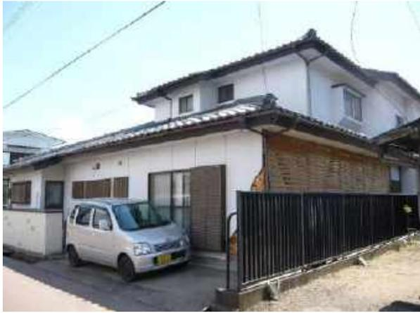
写真 2.1.27 ラスモルタル外壁が部分的に落下した例(白石市)
