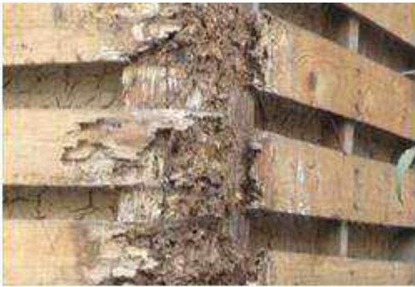
写真 2.1.29 生物劣化による柱部分の腐朽(福島市)
