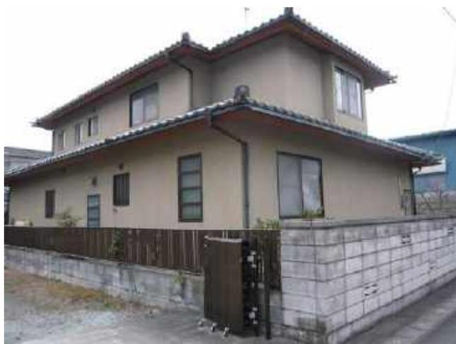
写真 2.1.19 損傷が認められなかったラスモルタル外壁の例(名取市)ひび割れ無
