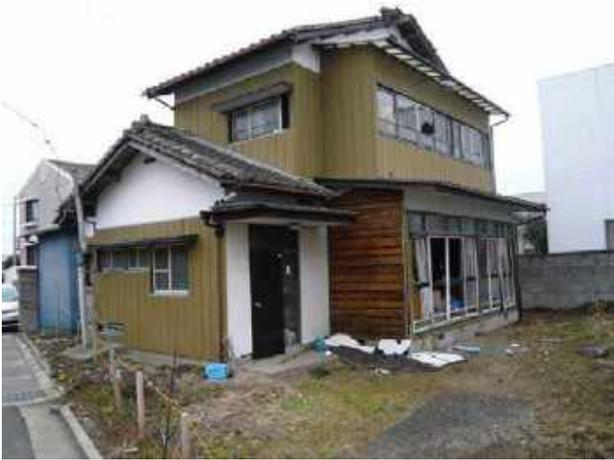
写真 2.1.23 ラスモルタル外壁が部分的に落下した例(名取市)
