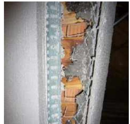
写真 3.3.27 コーナー部の破断
