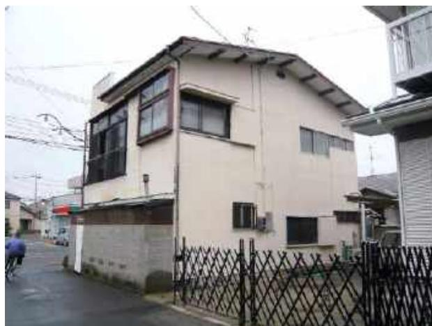
写真 2.1.20 開口部のひび割れのためのラスモルタル外壁の例(名取市)
