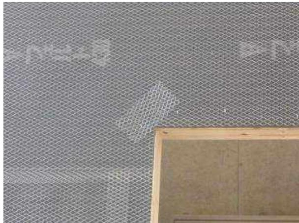
写真 3.2.5 ラス張付け(開口補強)
