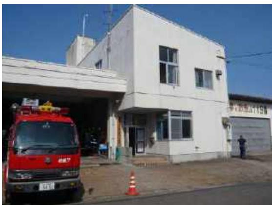
写真 2.1.12 鉄骨造ラスモルタル外壁
