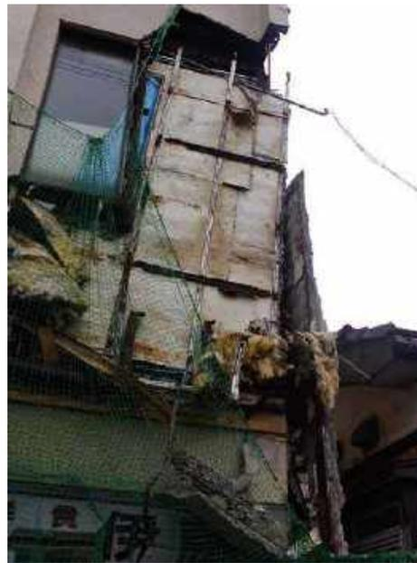
写真 2.1.11 写真 2.1.10 の拡大(内壁および断熱材の鋼製下地周りに結露跡が見られる)
