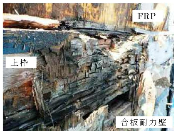
写真 4.3.2 外装除去後のバルコニー外壁(築 5 年)
