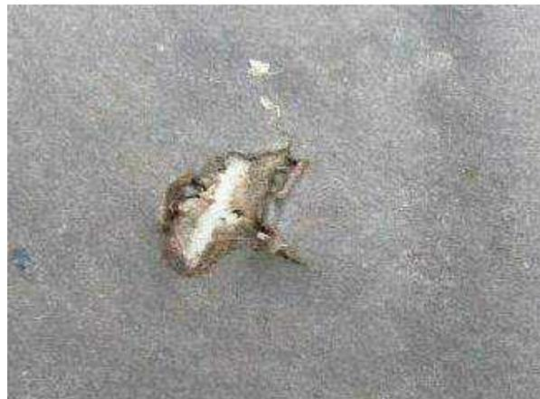
写真 2.1.26 平ラスの破断状況(名取市)
