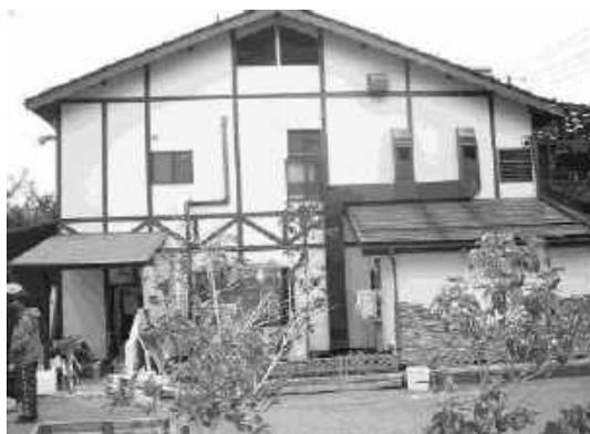
写真 2.1.6 ラスモルタル外壁の建物
