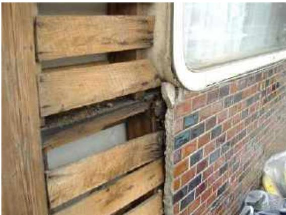
写真 2.1.8 サッシ取り合い部からの漏水による木下地およびステーブル・ラスの腐食によるラスモルタル外壁のはく落例
