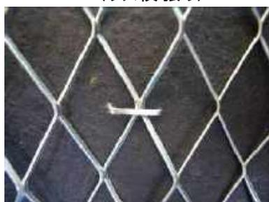
写真 3.3.12 ラス縦張りのステーブル
