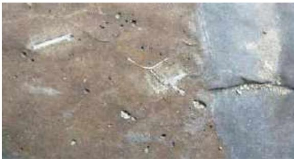
写真 2.1.25 線径の細い平ラスが使用されている(名取市)
