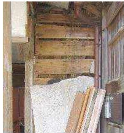
写真 2.1.9 雨樋閉塞による漏水で筋かいが腐朽し、変形が大きくなり脱落したラスモルタル外壁の例(西本町)
