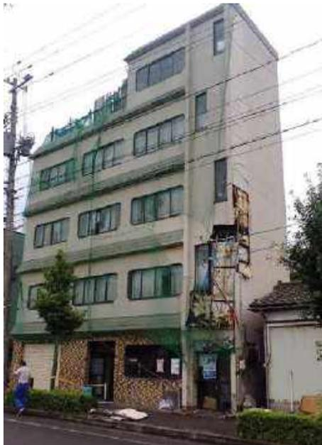
写真 2.1.10 外壁下地腐食によるリブラスモルタル外壁の脱落(小倉町)築 30 年以上
