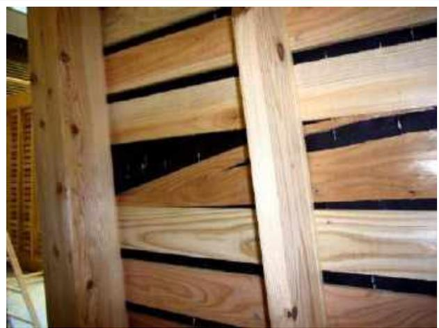
写真 3.3.22 ラス下地板の割裂
