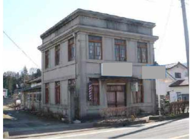
写真 2.1.22 損傷が認められなかったラスモルタル外壁の例(白石市)昭和8年竣工ワイヤラス
