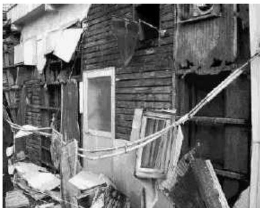
写真 2.1.4 下地の腐食
