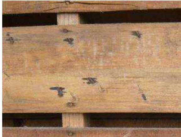
写真 2.1.24 ラス下地板にステープルが残っている状況(名取市)
