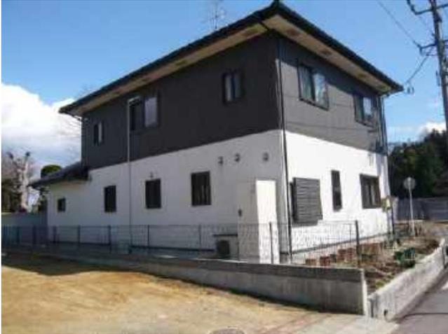
写真 2.1.21 損傷が認められなかったラスモルタル外壁の例(白石市)
