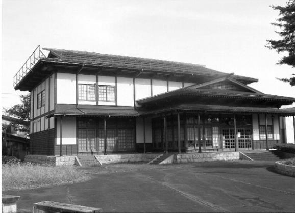
写真 2.1.7 ラスモルタル外壁の建物
