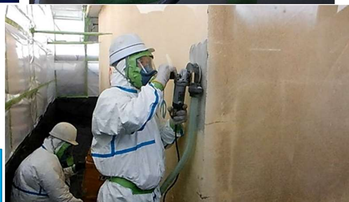
集じん装置付きディスクグラインダー ケレン工法の発塵状況
