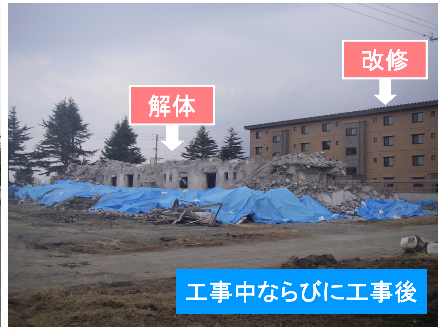
3棟を解体、他は塗替えなど改修
