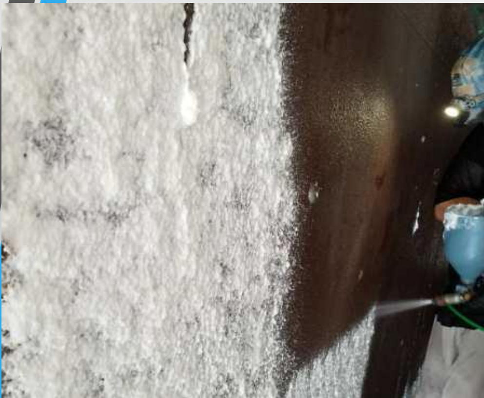
生分解性剥離剤を吹付にて塗布
