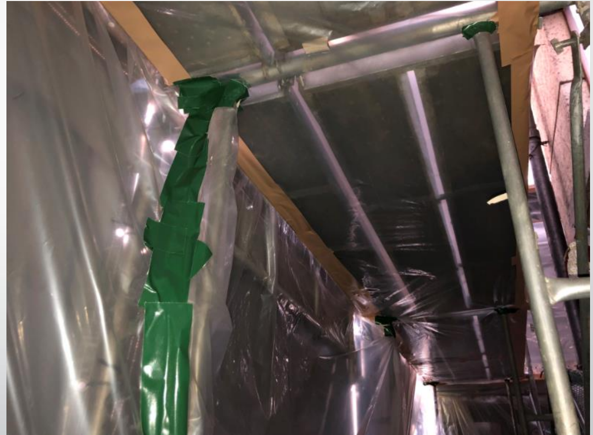
足場板下部養生
