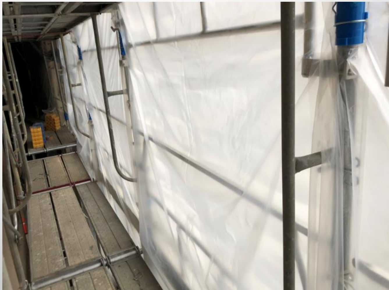
足場背面養生
