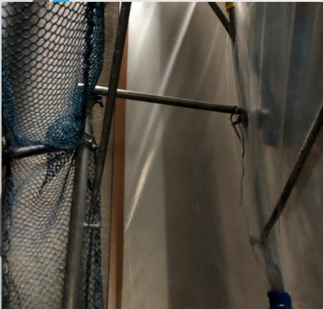
足場端部の間仕切り養生
