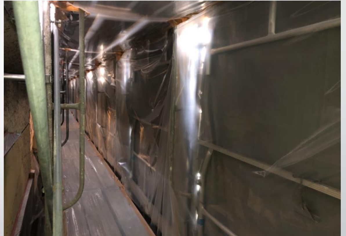
足場内隔離養生
