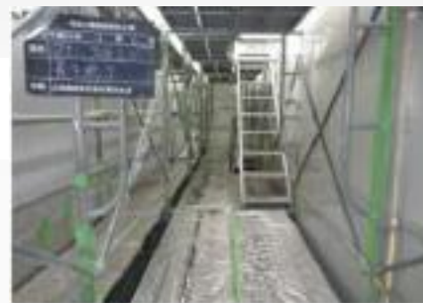
隔離養生内部
