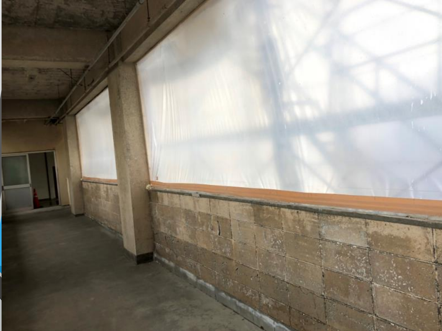
開口部間仕切り養生
