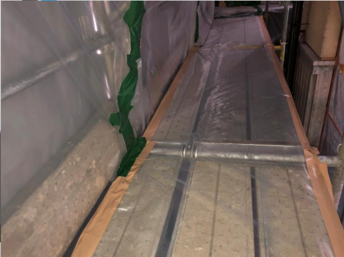
足場板上部養生
